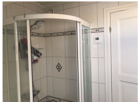
Bildet viser dør i våtsonen.
